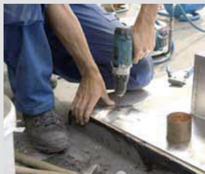
**Bleche miteinander verbinden** In der Werkstatt und auf der Baustelle müssen immer wieder Blechteile zusammengesetzt werden. Sie werden genietet, gefalzt oder punktgeschweisst.
