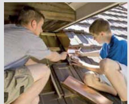
**Montage auf der Baustelle** Mit der Montage der Blechprofile wird die Arbeit auf der Baustelle abgeschlossen. Diese Arbeit bleibt lange sichtbar. Darum ist besondere Sorgfalt nötig!
