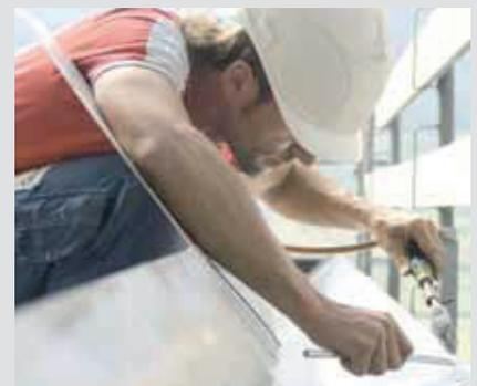
**Löten macht die Blechverbindung dicht** Verbindungen zwischen Blechen müssen abgedichtet werden. Sie werden mit Lötzinn oder Hartlot gelötet oder auch geschweisst.
