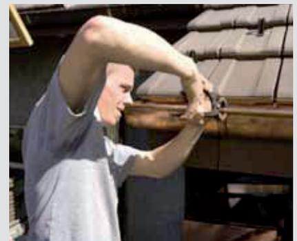
**Montage von Befestigungselementen** Ablaufrohre oder Abdeckungen müssen irgendwie befestigt werden. Dazu verschrauben oder nageln die Berufsleute Rohrschellen, Rinnenhaken usw.
