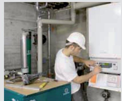
Installieren von Gas-Heizgeräten Die Berufsleute montieren moderne Gas-Heizgeräte für die Warmwasser-Bereitung. Sie verfügen über ein Grundwissen für deren sichere Montage.
