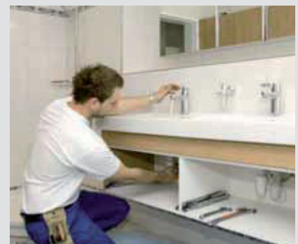
Montage der Apparate Mit dem Einbau von Apparaten und Garnituren krönen die Sanitärinstallateurinnen und -installateure ihre Arbeit. Jetzt würde man jeden Kratzer sehen.
