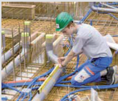
Einlegearbeit im Rohbau Noch während des Rohbaus verlegen die Berufsleute die Leitungen etwa für Abwasser auf die untere Eisenarmierung der Decke. Diese Arbeit ist anstrengend.
