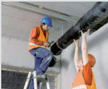
**Montage von Rohrleitungen** Zu den wichtigsten Aufgaben der Berufsleute gehört die Montage der Heizungsrohre, von Apparaten, Geräten und Armaturen.
