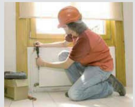
**Heizkörper verlangen besondere Sorgfalt** Kurz vor Bauvollendung erfolgt die Endmontage der Heizkörper (Radiatoren). Sie verlangt einen sorgfältigen Umgang mit der Umgebung und dem Material.
