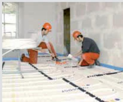
**Verlegen der Bodenheizung** Die Bodenheizungsrohre werden auf die zuvor verlegten Dämmplatten in Schlangen genau nach Plan verlegt.
