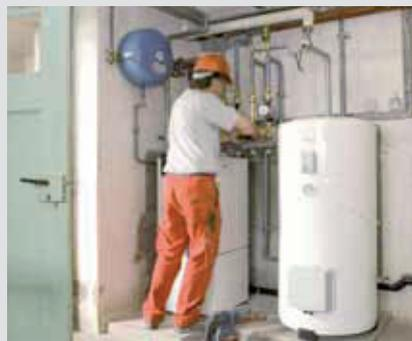
**Wärmespeicherung** Heizungsinstallateurinnen und -installateure können Heizwasserspeicher und ähnliche Geräte installieren und an das Leitungsnetz anschließen.
