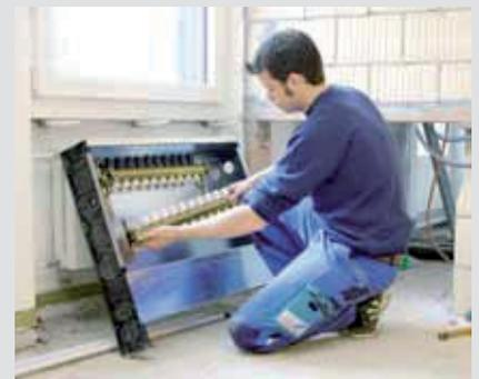
**Einbau von Apparaten und Armaturen** Heizungsinstallateurinnen und -installateure können Thermostaten, Fühler und Regelventile nach Montageanleitung des Lieferanten einbauen.
